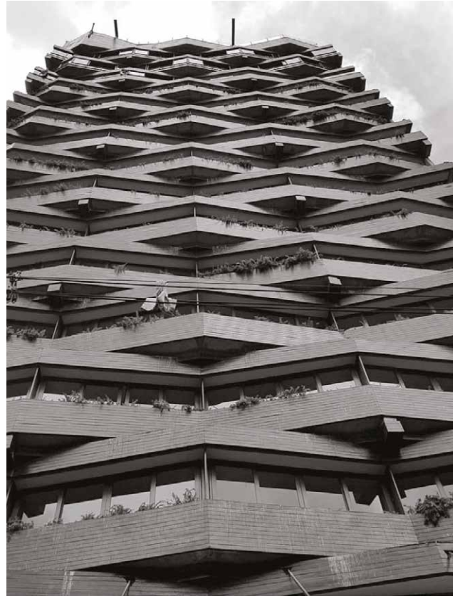
Arquitectónico © Galo Cajas
