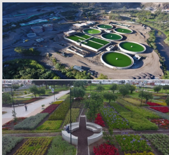
Parques y planta de tratamiento de aguas residuales Ambato
